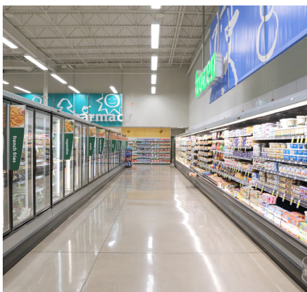
Supermarkeds-køl, som fx er bundet op på CO2-løsninger, som også er fremtiden. HFC kølemidler er stadig brugt indtil udfasning.
